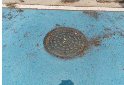
<송수관로 점검구(B1-1) 맨홀 덮개 상태양호>
