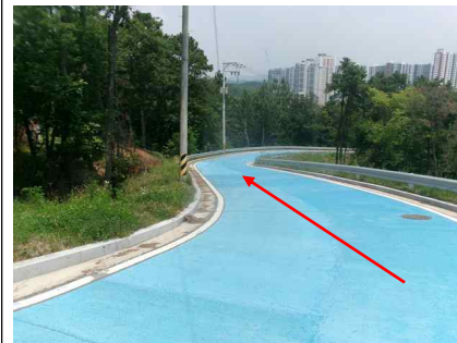
<송수관로 (Sta.4+0.0) 포장 및 지반 상태양호>
