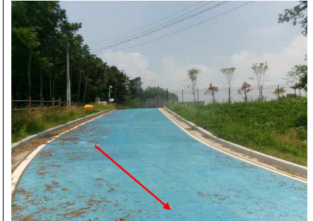
<송수관로 (Sta.3+16.1) 포장 및 지반 상태양호>
