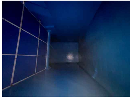
<배수지 2지 전경>
