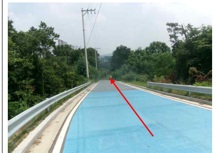
<송수관로 (Sta.7+16.7) 포장 및 지반 상태양호>
