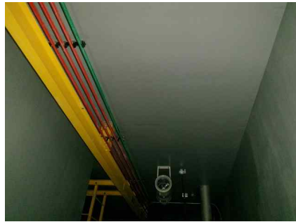
<유출밸브실 상부슬래브 상태양호 >
