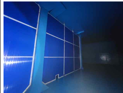
<배수지 2지 기둥 상태양호>
