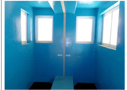
<검수실 내부 상태양호>
