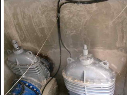
<송수관로 Sta.4+0.0(유량계실) 벽체 상태양호>
