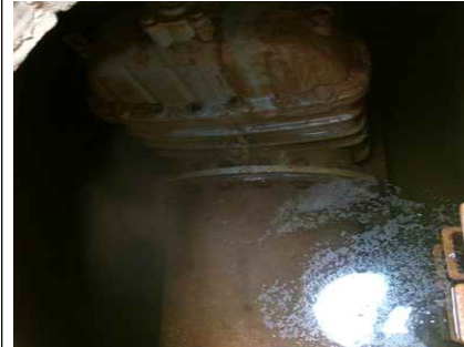
<송수관로 Sta.17+1.5(점검구) 도장 상태양호>
