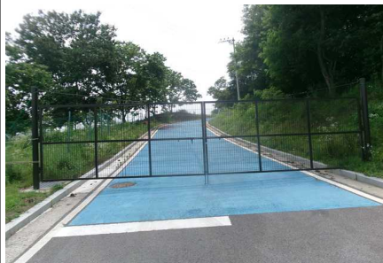
<송수관로 Sta.17+1.5 포장 상태양호>
