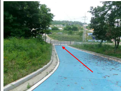
<송수관로 (Sta.14+15.8) 포장 및 지반 상태양호>
