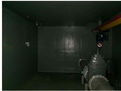
<유입밸브실 벽체 상태양호>
