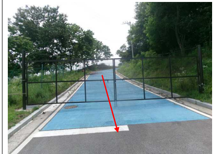
<송수관로 (Sta.17+1.5) 포장 및 지반 상태양호>
