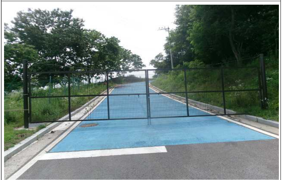
<화성비봉 공공주택지구 밖 배수지 및 진입도로 중 배수지 및 송수관로(송수관로)>
