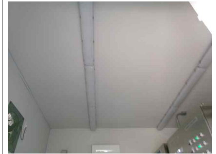
<전기실 내부 상부슬래브 상태양호>
