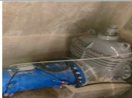
<송수관로 Sta.4+0.0(유량계실) 기초 상태양호>
