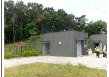
<전기실 및 계단실 외부 전경>
