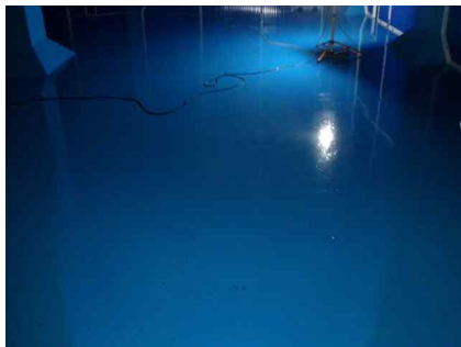
<배수지 1지 바닥슬래브 상태양호>
