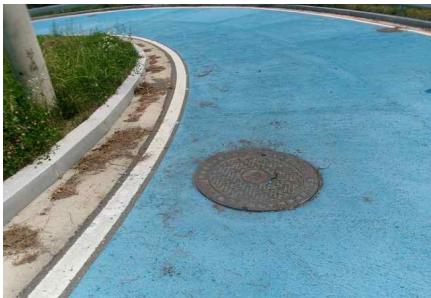
<송수관로 유량계실 맨홀 덮개 상태양호>
