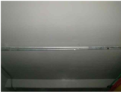
<유입밸브실 상부슬래브 상태양호>
