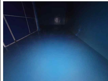
<배수지 2지 바닥슬래브 상태양호>
