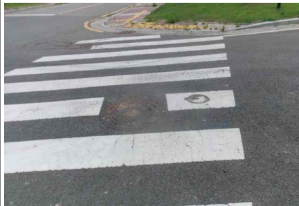
<송수관로 점검구(B1-2) 맨홀 덮개 상태양호>
