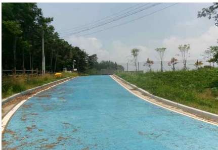
<송수관로 Sta.3+16.1 포장 상태양호>
