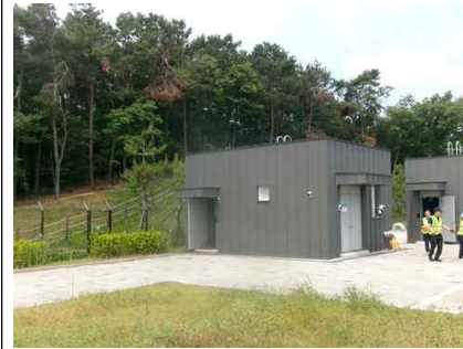
<전기실 외부 상태양호>
