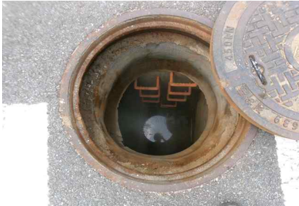
<송수관로 점검구(B1-2) 사다리 설치 상태양호>
