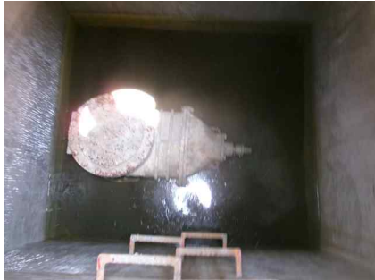
<송수관로 Sta.3+16.1(점검구) 밸브실 채수(H=0.3m)>
