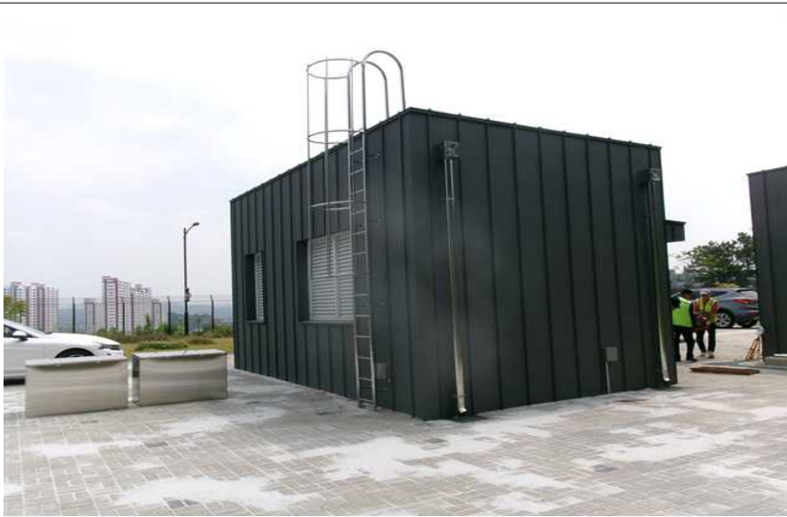
<화성비봉 공공주택지구 밖 배수지 및 진입도로 중 배수지 및 송수관로(배수지)>
