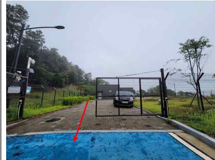
<송수관로 (Sta.1+9.0) 포장 및 지반 상태양호>
