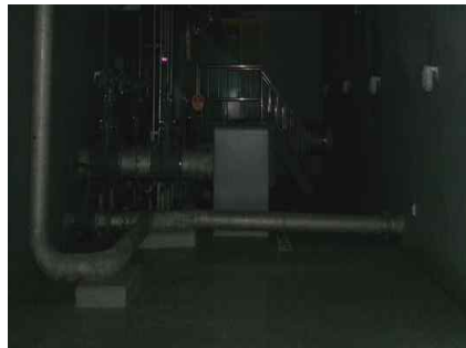
<유출밸브실 바닥슬래브 상태양호 >
