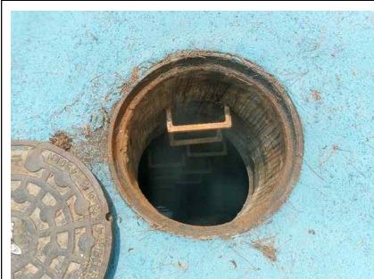
<송수관로 점검구(B1-1) 사다리 설치 상태양호>
