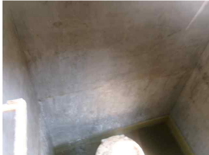
<송수관로 Sta.3+16.1(점검구) 벽체 상태양호>
