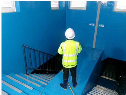
<내부 개별부재 외관조사>
