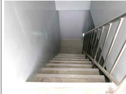
<계단실 내부 전경>
